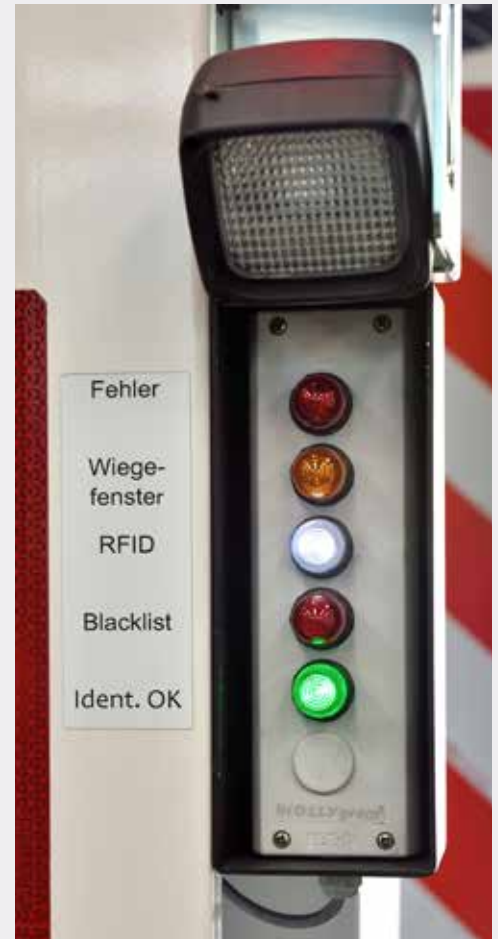
Les lampes de signalisation permettent aux chargeurs de contrôler le cycle de pesage ainsi que la gestion des puces
